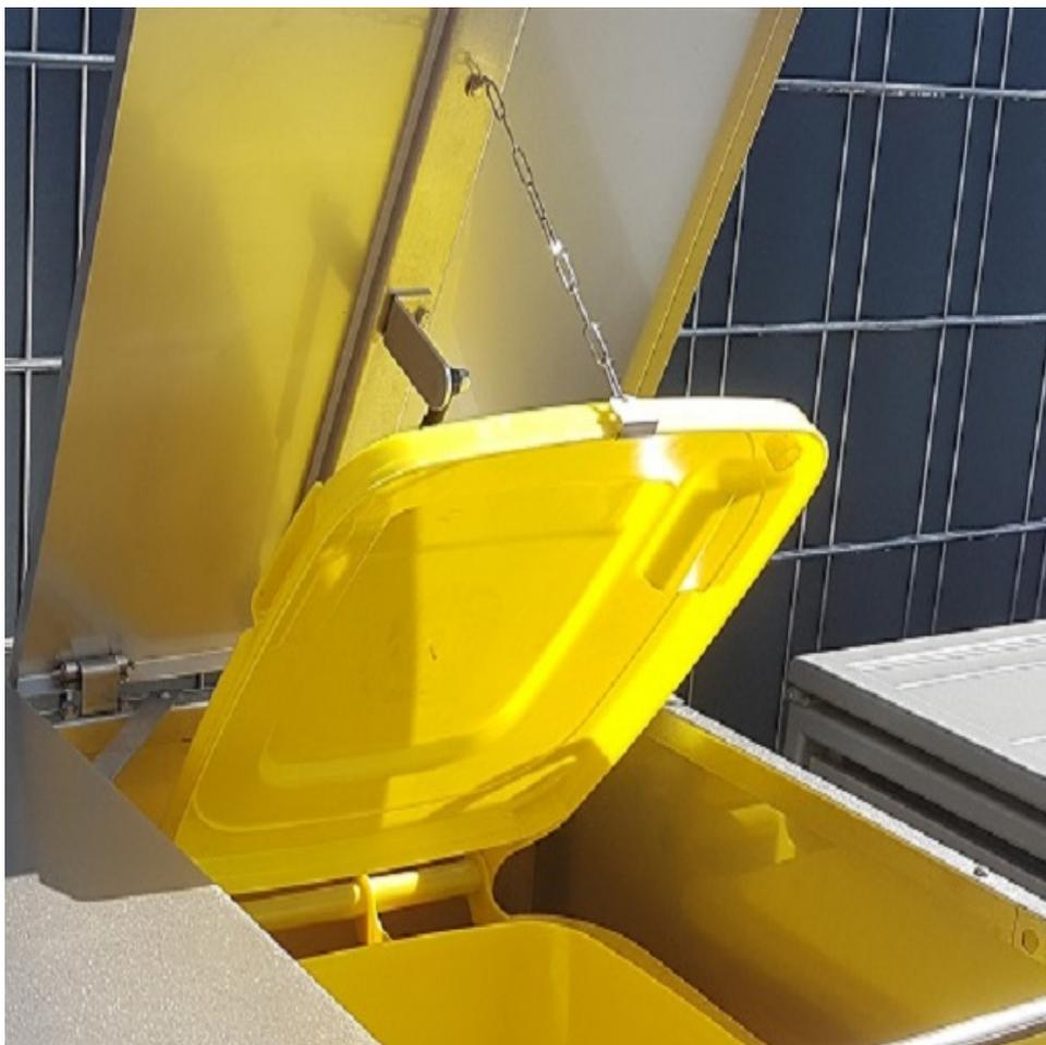
**Klappdach mit Gasdruckdämpfer:**
